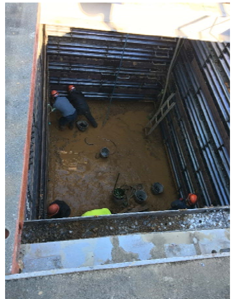
推進立坑築造工事(2021.01.15)
